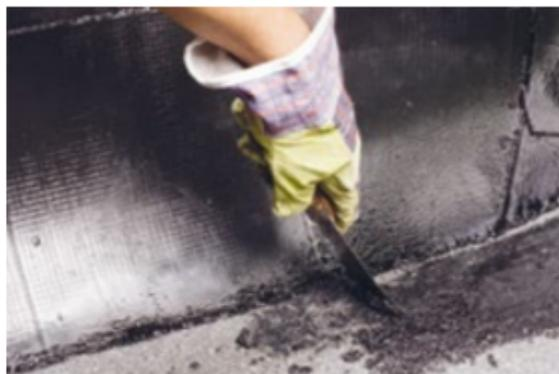
Наплавьте дополнительный верхний слой на всю плоскость парапета с одной стороны угла парапета. Материал заведите на фасадную часть парапета на 50 мм.
