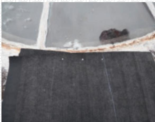
По полученному сектору подрезать подкладочные ковры. Оставшиеся отрезки можно использовать при монтаже последующих секторов.
