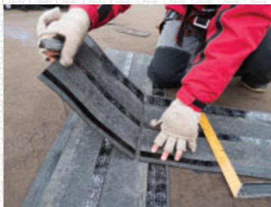
Разметить горизонтальную линию по основанию купола с помощью шнурки - она будет служить стартовой линией для укладки гибкой черепицы.
