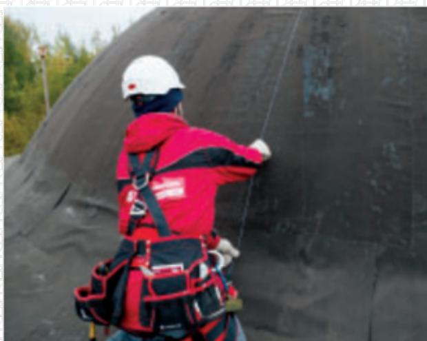
Нанести с помощью шнурки вертикальную линию разметки - от центра купола к отметкам на
