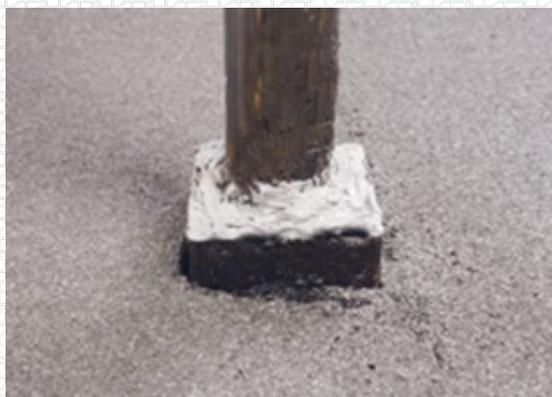
Вместо полиуретанового герметика можно также использовать Мاستику кровельную горячую ТЕХНИКОЛЬ № 41 («Эврика») — следует залить горячую мастику в стакан до края и сверху нанести сланцевую посыпку.
