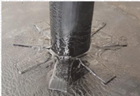
Подготовьте верхний оклад из материала Техноэласт ЭКП на вертикальную поверхность.
