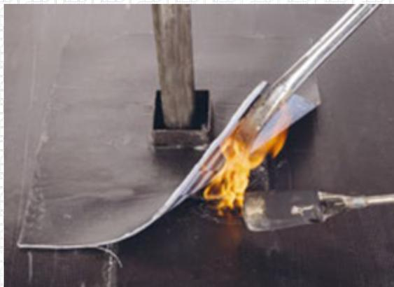
Наплавьте верхний слой кровельного материала
