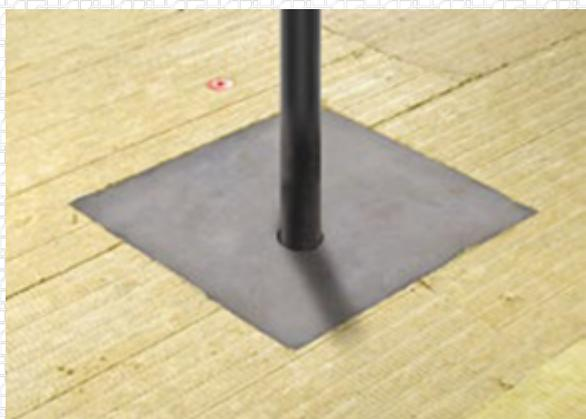
Перед установкой листа прорежьте в заготовке круглое отверстие на 10 мм больше диаметра трубы воронки.
