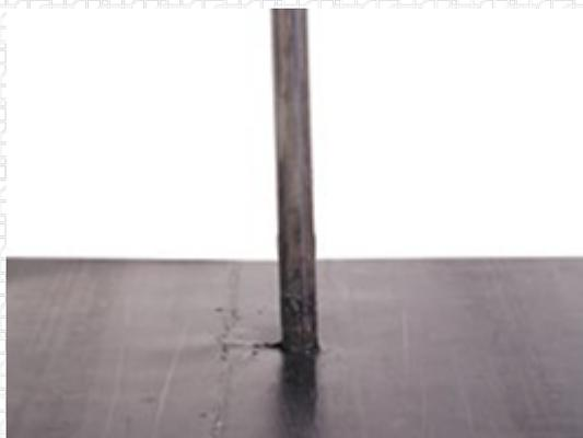
Разогрейте пламенем горелки область материала под установку фланца стакана.
