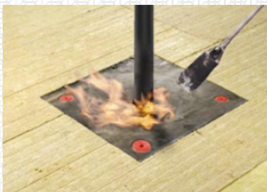
Установите стакан и вдавите фланец в разогретый материал. Следите за равномерным вытеком битумно-полимерного вяжущего из-под фланца стакана. Вытек обеспечит полную герметичность соединения.
