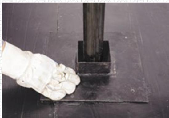
Закрепите металлический стакан в основании, используя минимум 4 крепежных элемента. В качестве крепежных элементов применяйте остроконечные саморезы ТЕХНОНИКОЛЬ EDS-S 4,8 мм с полиамидной гильзой.
