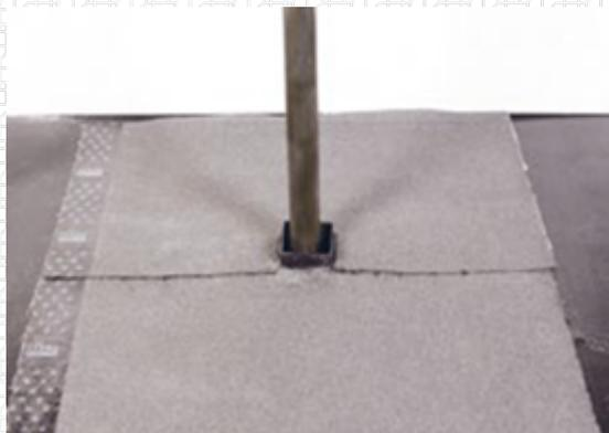
Заполните пространство между трубой и стенками стакана герметиком двухкомпонентным полиуретановым ТЕХНИКОЛЬ № 2К.
