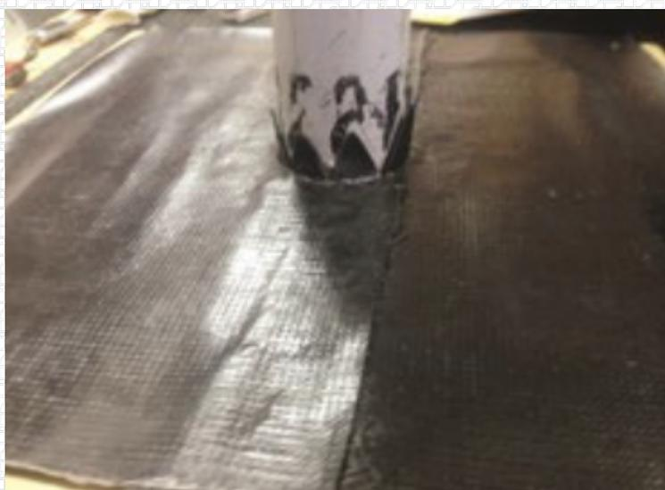
Подготовьте нижний оклад из материала Техноэласт ЭПП на вертикальную поверхность трубы.
