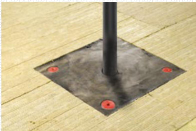
Разогрейте пламенем горелки слой усиления под установку фланца стакана.
