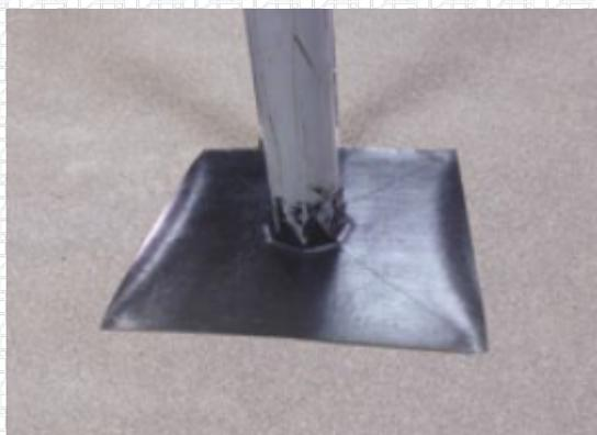
Наплавьте дополнительный слой усиления на горизонтальную поверхность. Следите за вытеком битума из-под кромки материала.
