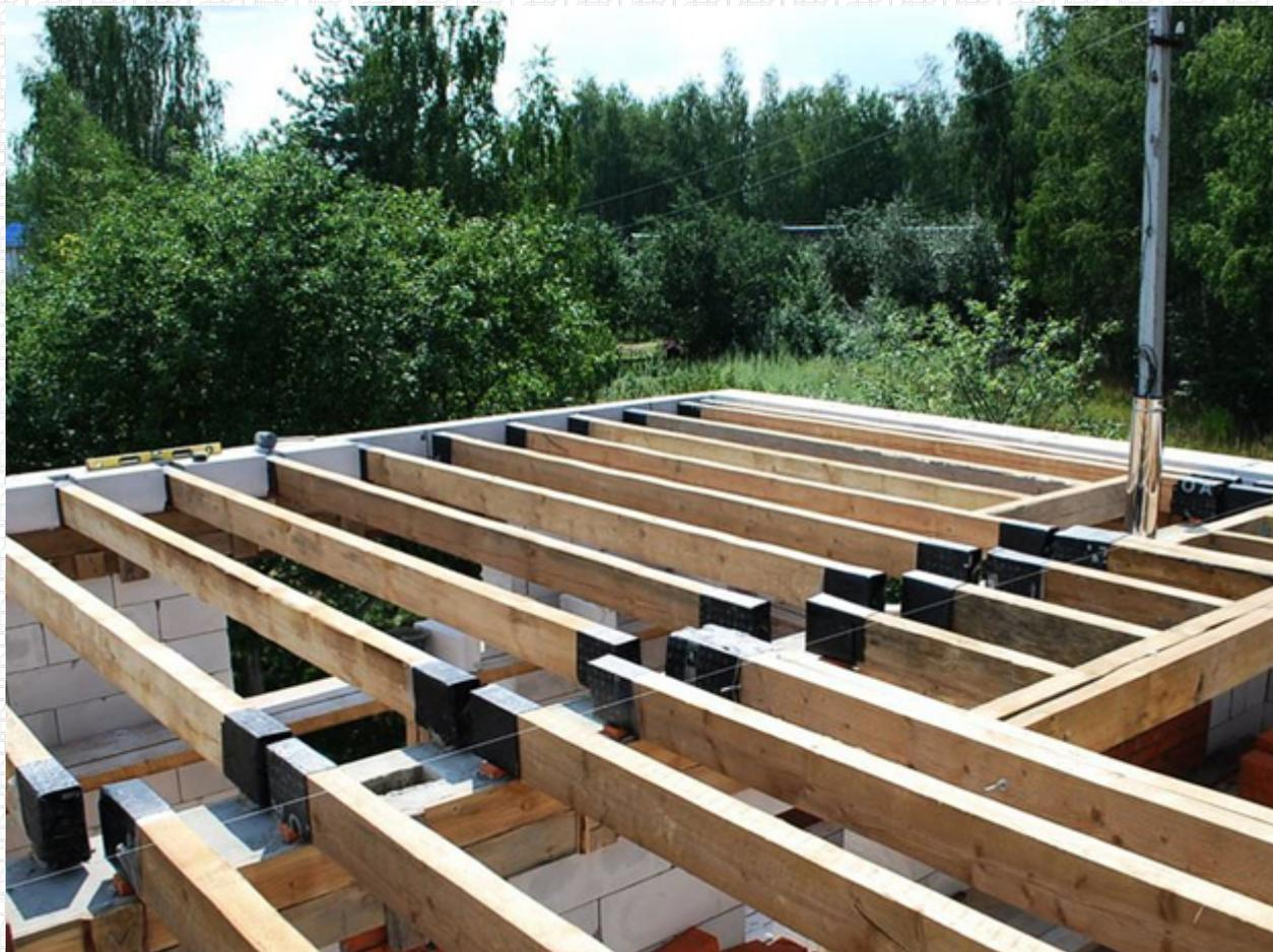
Перекрытия по деревянным балкам организуют в малоэтажных каменных и деревянных строениях. Такие перекрытия удобны для индивидуальных застройщиков. В качестве несущих элементов используют балки из хвойных пород.
