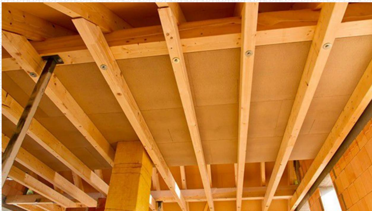
Их главным конструктивным элементом являются балки, которые обычно расположены через равные промежутки. Именно на них опираются элементы заполнения, которые и несут ограждающую функцию.
