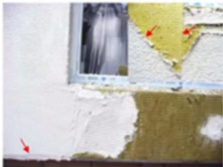
Армирование декоративной штукатуркой
