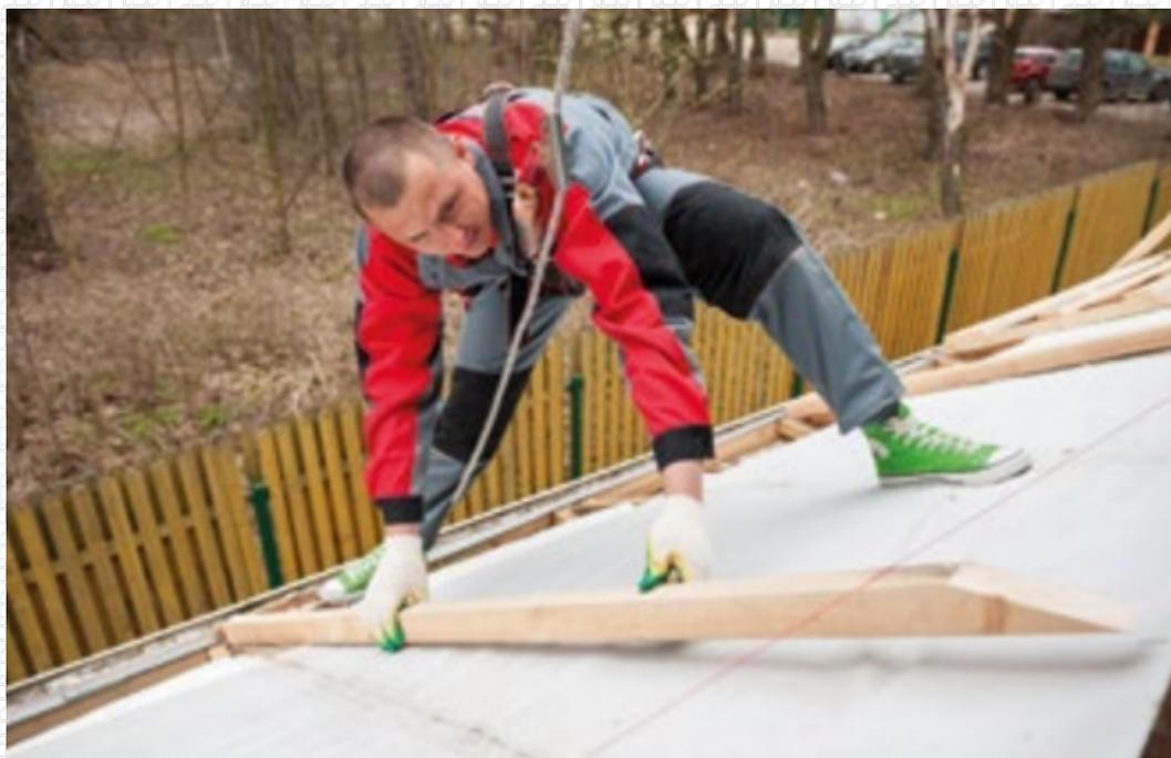
Вентиляционный канал над теплоизоляцией должен иметь высоту продуха 50 мм при угле ската больше 20°. При уменьшении угла наклона ската (менее 20°) высота продуха должна
