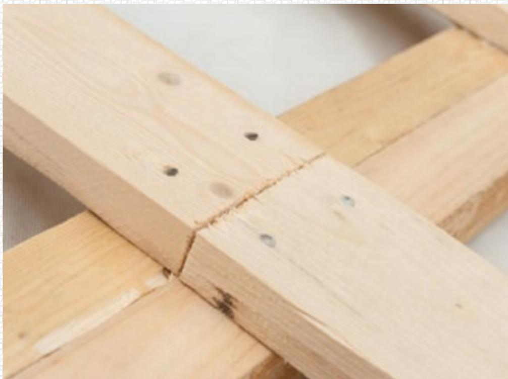
Стыки разреженной обрешетки в соседних горизонтальных рядах должны быть смещены минимум на один прогон стропил. Длина досок должна быть не менее чем два пролета стропил.
