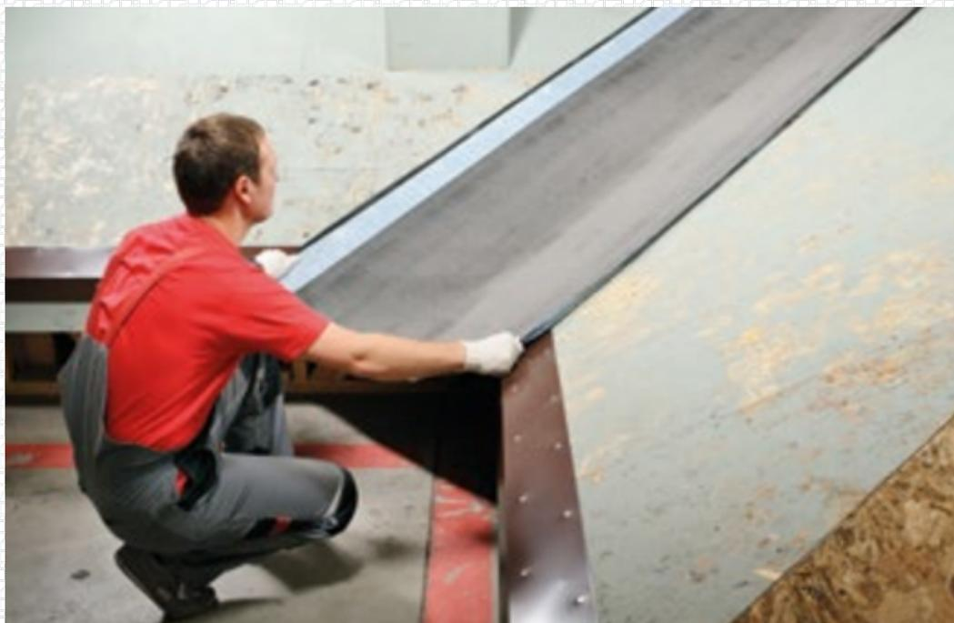
Произвести разметку, обрезать лишние части подкладочного ковра.
