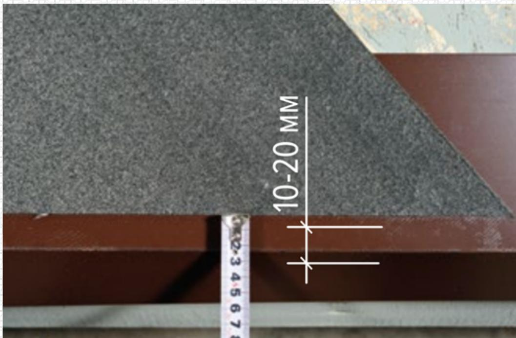
Снять защитную пленку, затем полностью приклеить полотно к основанию.
