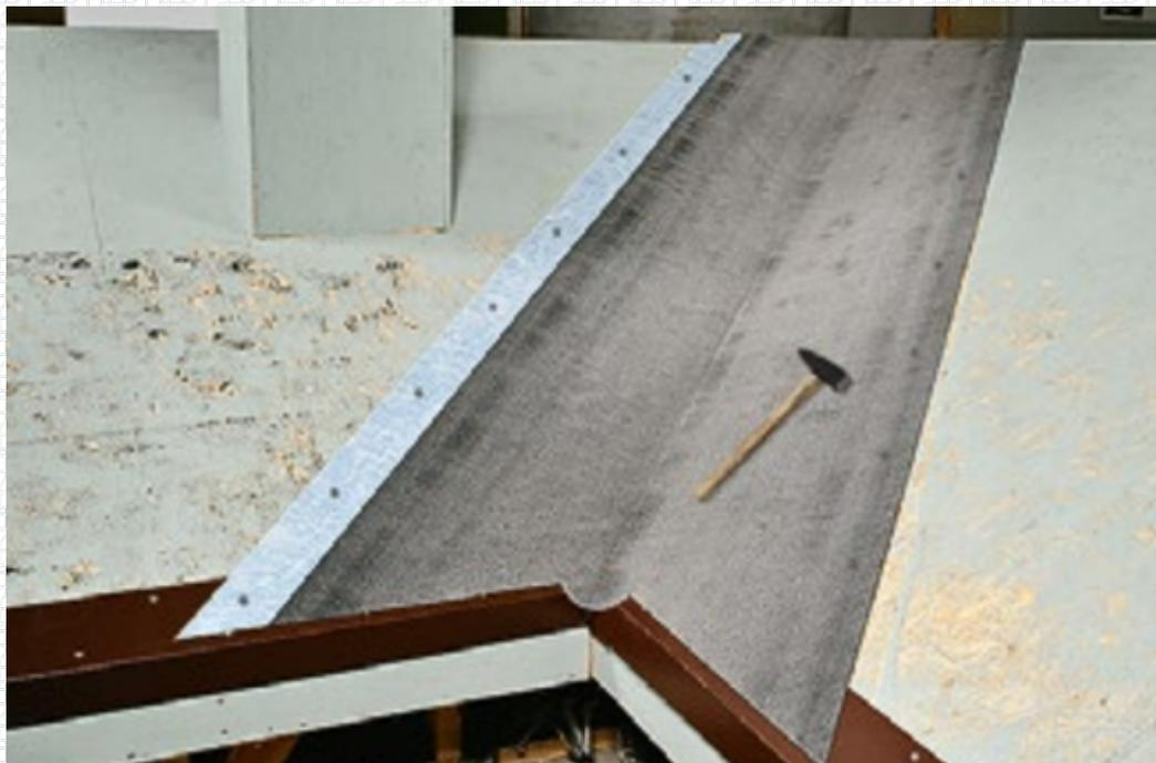
После укладки самоклеящегося подкладочного материал ANDEREP ULTRA в ендове необходимо смонтировать его на карнизном свесе.
