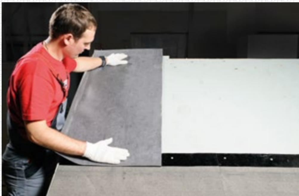
Так же, как и при монтаже самоклеящегося подкладочного материала, полотно подкладочного ковра примерить по месту.
