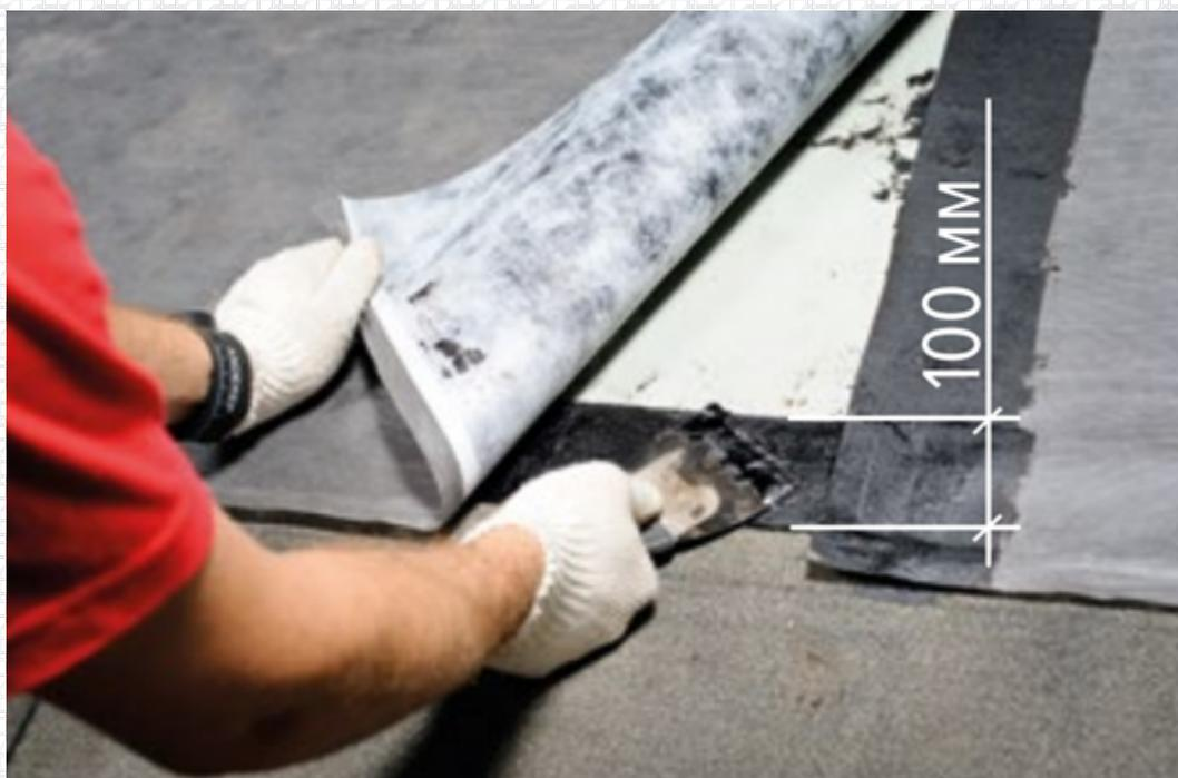
Следует обращать внимание на расстояние между торцами соседних полотен. Торцевые нахлесты соседних полотен материала должны быть разнесены минимум на 500 мм.
