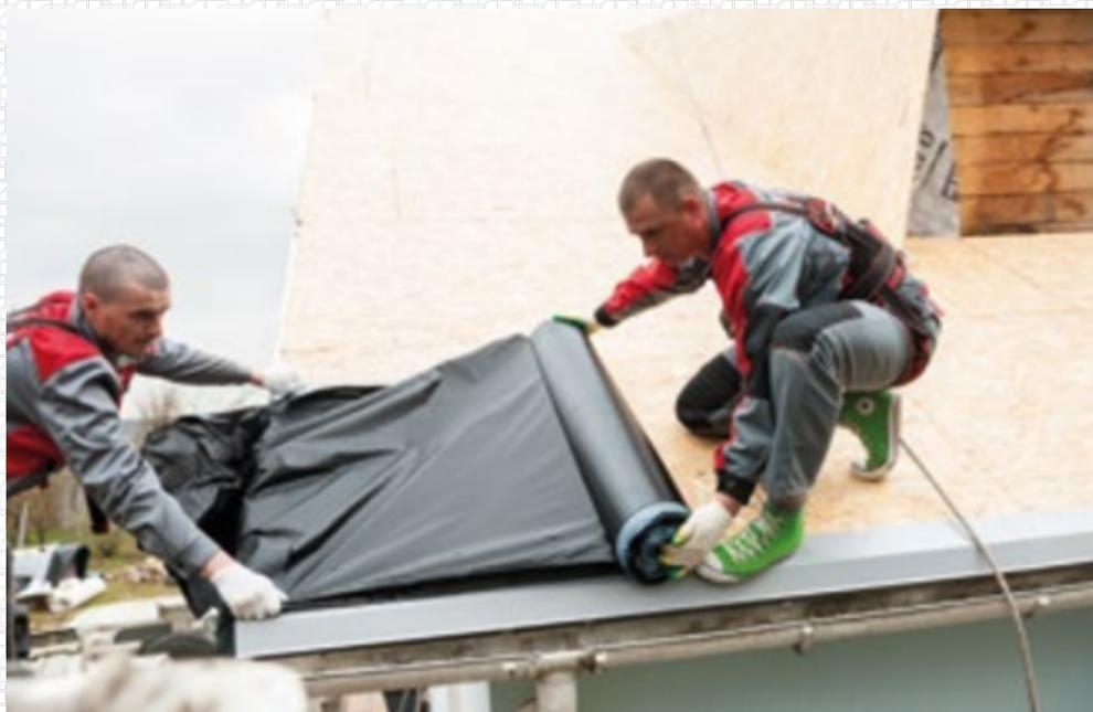
При температуре ниже +5 °С необходимо дополнительно закрепить подкладочный ковер вдоль верхней горизонтальной кромки при помощи кровельных гвоздей с отступом от края ковра 50 мм с шагом 300 мм.
