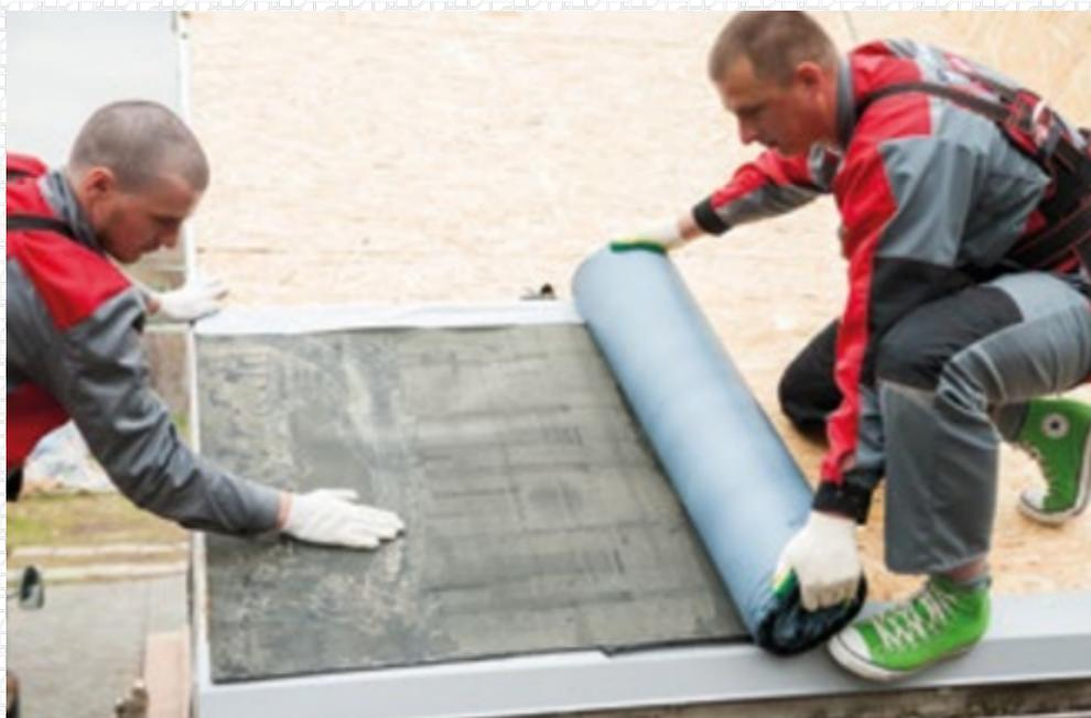
Приклеить к основанию оставшуюся часть полотна, одновременно раскатывая и снимая защитную пленку с рулона.
