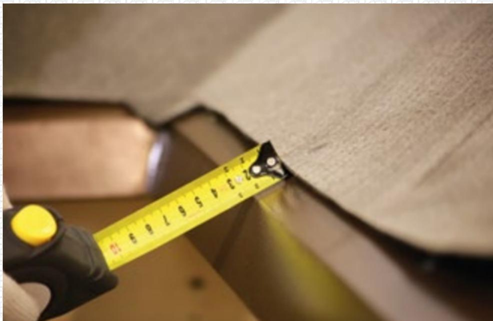
Укладку материала произвести с нахлестом в поперечном направлении 150 мм в месте сопряжения подкладочного ковра на карнизном свесе и ендовы, места нахлестов промазываются битумной мастикой ТЕХНОНИКОЛЬ ФИКСЕР толщиной не более 1 мм.
