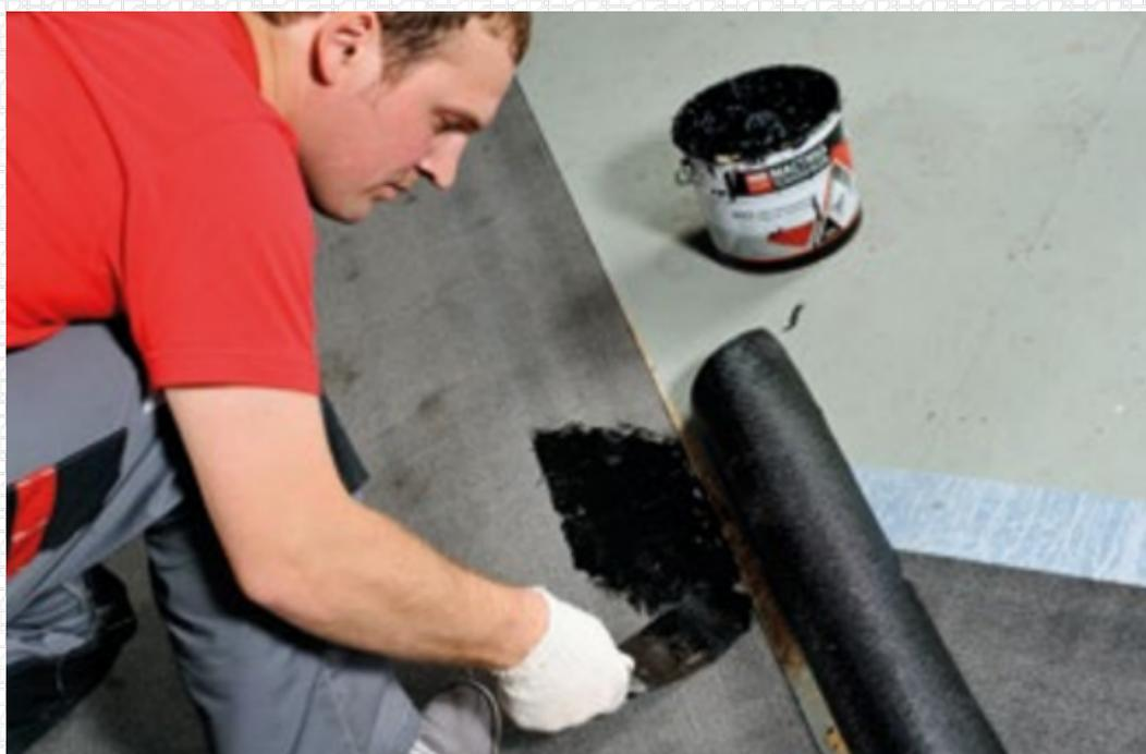
В поперечном направлении нахлест составляет 150 мм.
