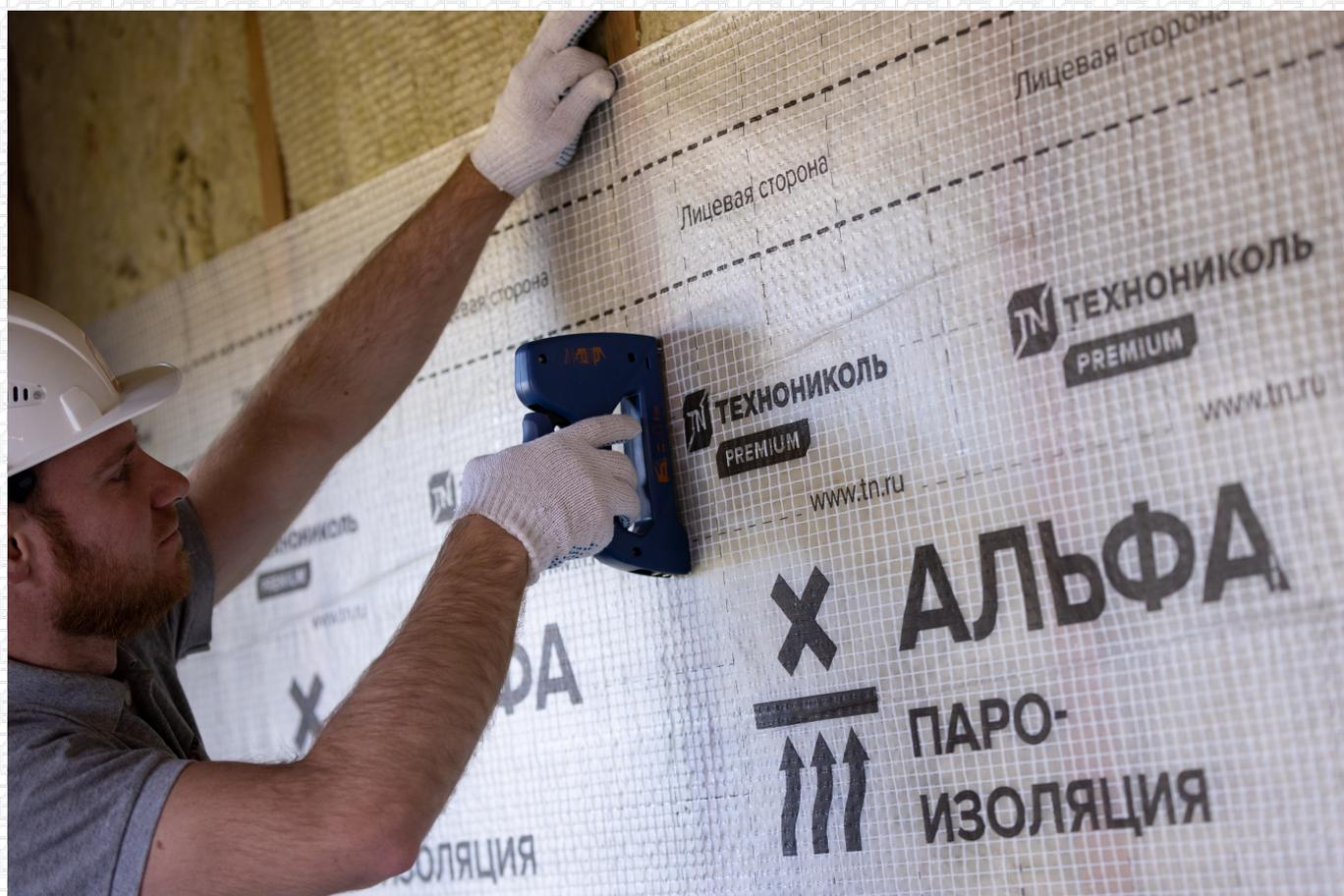
Монтаж пароизоляционных материалов производится внахлест. Ширина нахлеста должна составлять не менее 100 мм. Рулоны предварительно фиксируются на стропилах или нижнем настиле скобами степлера или гвоздями с широкой шляпкой. Дополнительное крепление обеспечивается каркасными брусками или профилями внутренней отделки.
