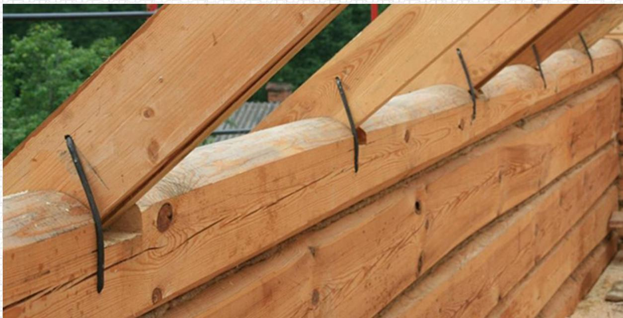
Сначала набиваем в торцах дополнительную планку в один уровень со стропильными ногами.
