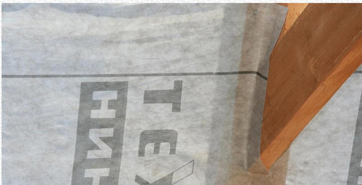
В местах нахлеста мембраны друг на друга пароизоляционную мембрану нужно надежно скреплять между собой двусторонним скотчем.
