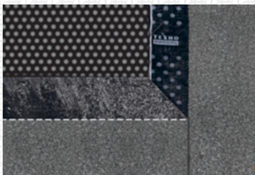
Торцевые нахлесты соседних полотен кровельного материала Техноэласт ЭКП должны быть смещены относительно друг друга не менее чем на 500 мм:
