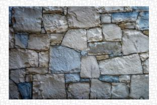
При этом элементы укладываются с перевязкой швов и соединяются цементно-песчаным или полимерным раствором. Также при небольшой высоте стены возможно соединение легких блоков при помощи специальной клей-пены.
