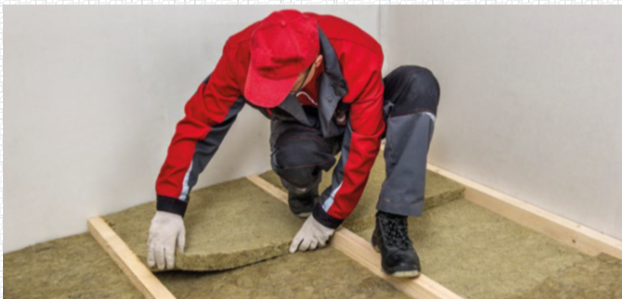
При укладке второго слоя плит необходимо соблюсти разбежку швов и уложить плиты со сдвигом относительно первого слоя.
