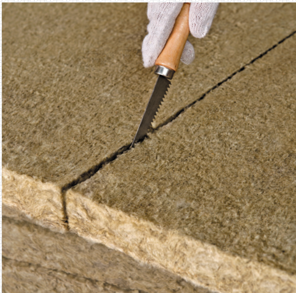
Монтаж теплоизоляции враспор между лагами:
