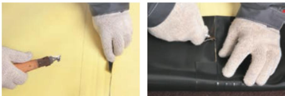
Проварите Т-образный шов автоматическим аппаратом. Усиьте все Т-образные пересечения мембран, установив заплатки. Для этого вырежьте заготовку размером 120x120 мм из мембраны LOGICBASE V-SL.
