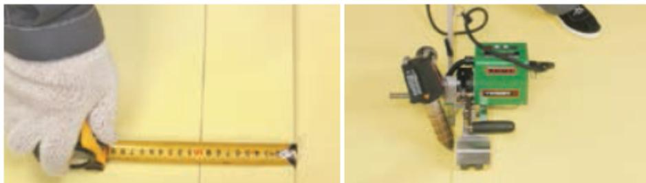
Совместите край соседнего полотна с маркировочной полосой и следите за тем, чтобы раскатка была ровной. Выполните продольные и поперечные швы автоматическим аппаратом с образованием проверочного канала.
